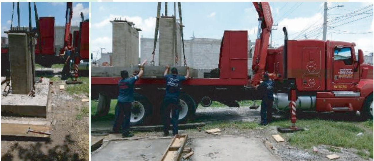
Ejemplo de cimentación (prefabricada)
